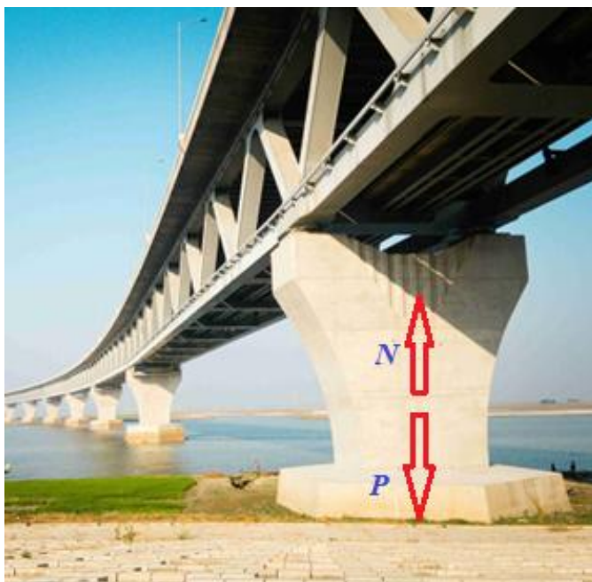
1-rasm. Daryo ustiga qurilgan ko'priknig umumiy ko'rinishi.
