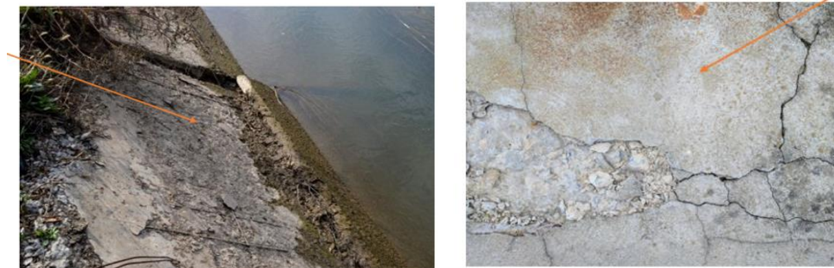
1-расм. Суғориш тизимларини лойқа-чўкиндилардан тозалашда юзага келадиган ҳолатлар
