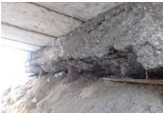
2–расм. Кўприк четки таянларининг таянчларини характерли емирилишлари келадиган
